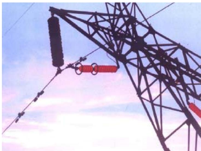
شکل ۴۵) استفاده از برقگیر خط بر روی دکل
