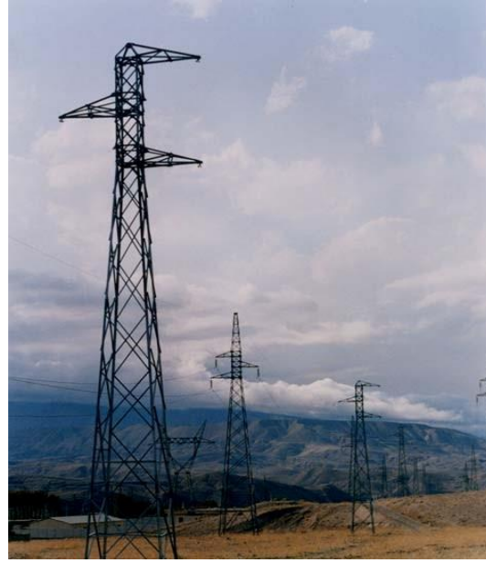
شکل ۱۳) دو نمونه از شمای کلی دکل ها با آرایش مثلثی فاذا
