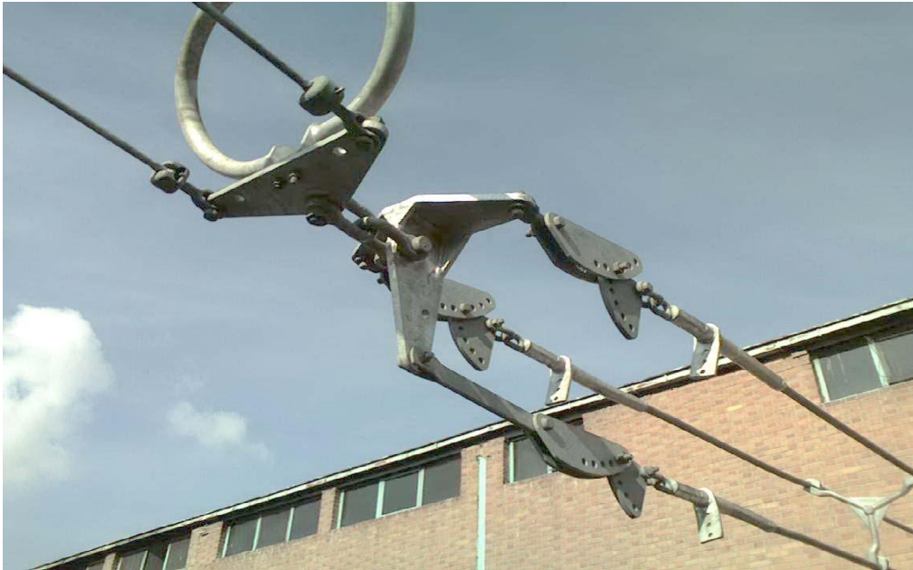
( استفاده از ۴۰ شکل , Socket Clevis , Yoke Plate , Arcing Rocket , Shackle ,
