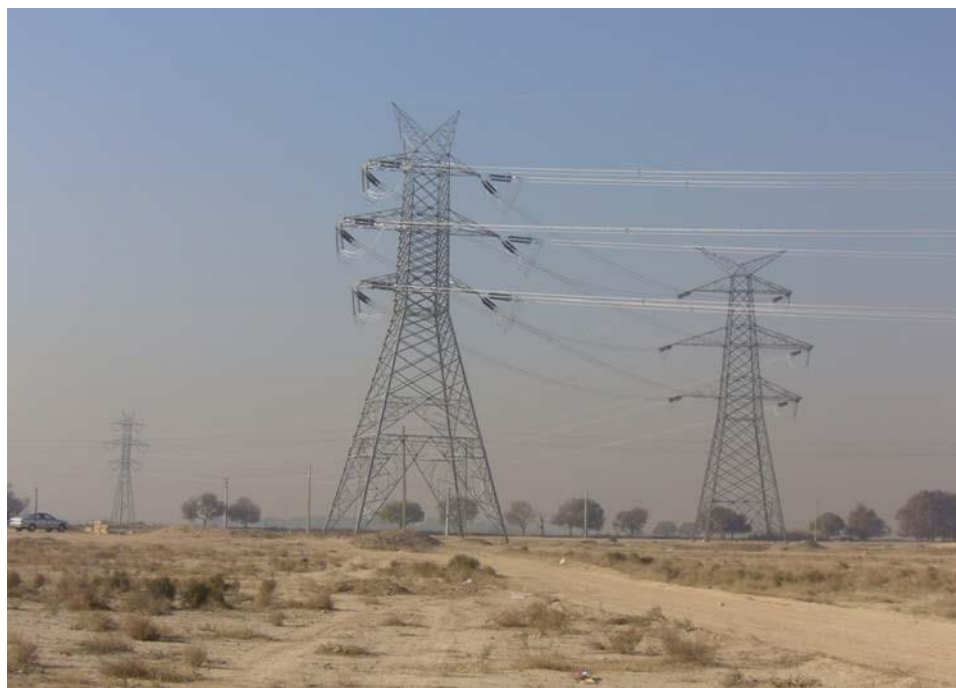
شکل ۱۵) نمایی از دکل های کششی
