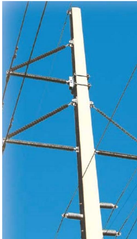
شکل ۲۷ کاربرد مقره اتکایی بعنوان بازوی دکل
