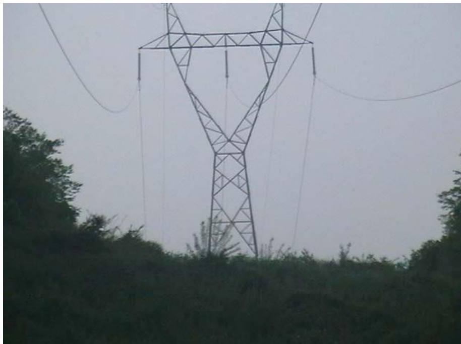
شکل ۱۴) نمایی از یک برج آویزی
