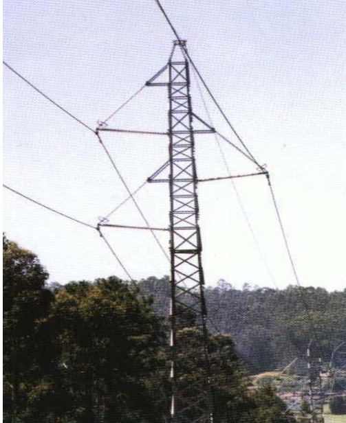
شکل ۱۳) دو نمونه از شمای کلی دکل ها با آرایش مثلثی فاذا
