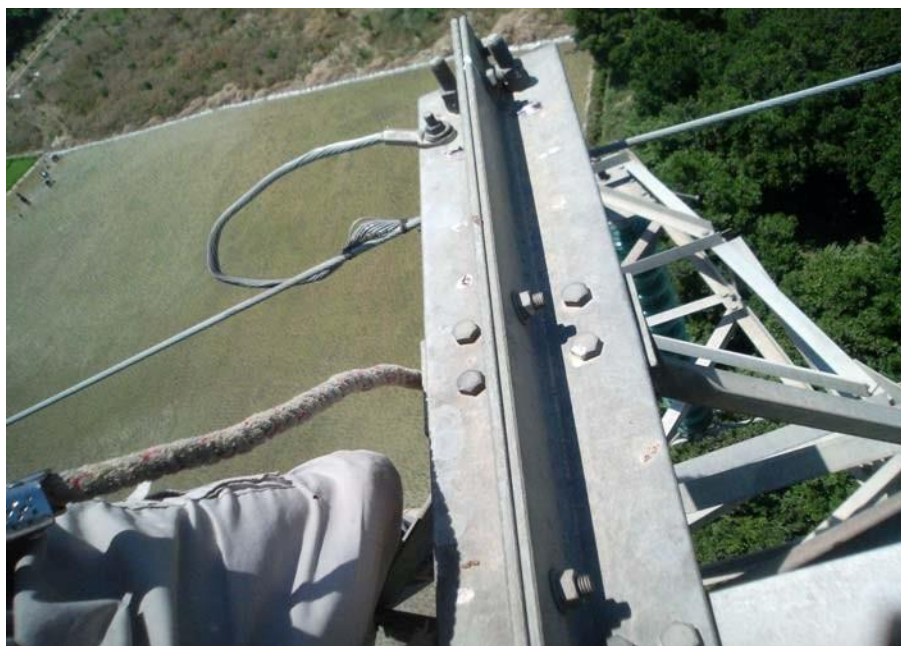
شکل ۴۲) اتصال سیم محافظ هوایی به بدنه دکل
