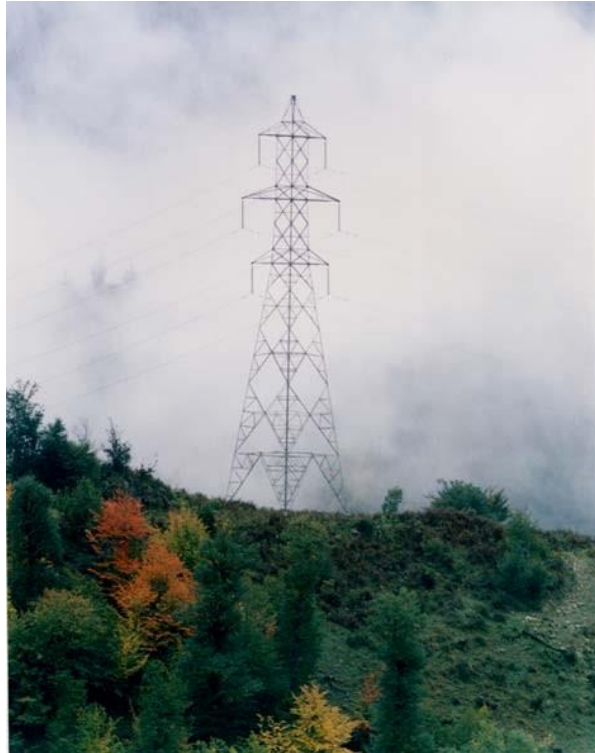
شکل (۱۱) خط انتقال با آرایش عمودی فازها
