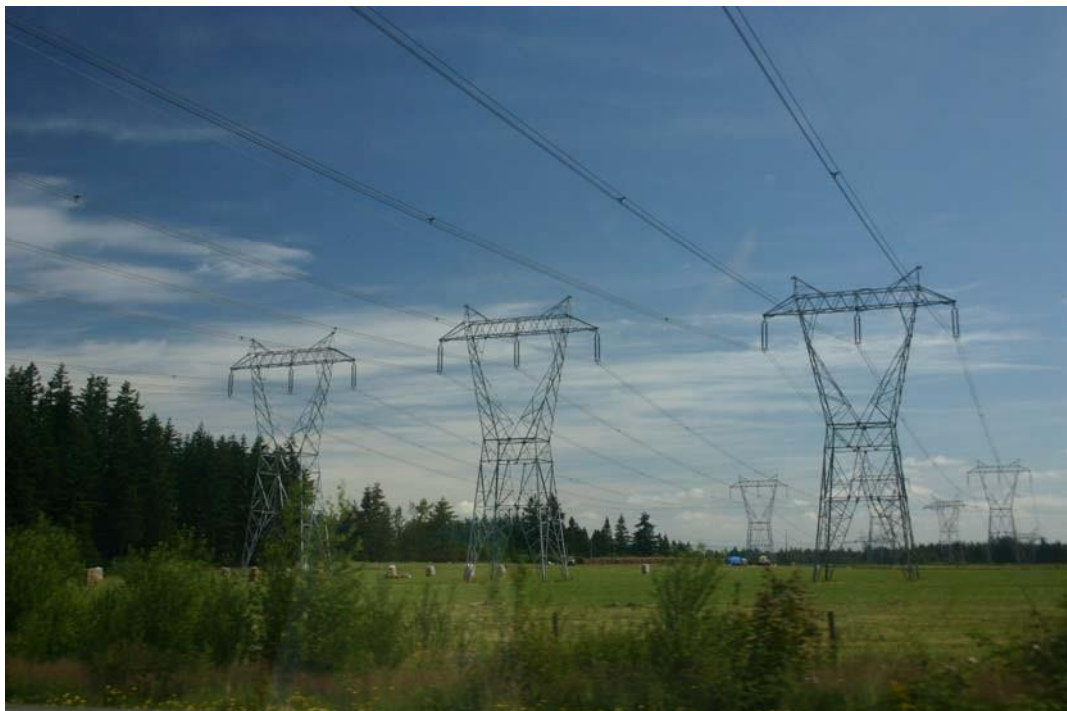
شکل ۱۰) برج با آرایش افقی هادیها
