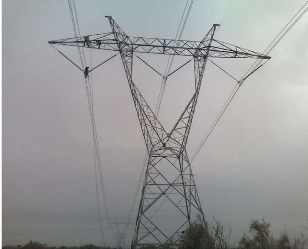
شکل ۱۷) نمایی از خط انتقال تکمداره
