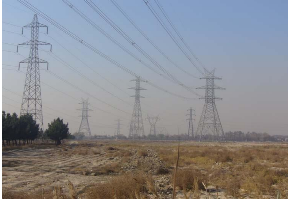
شکل ۱۸) نمایی از خط انتقال دومداره
